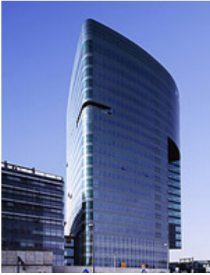
Tech Gate Tower in Wien, Holzbauer & Partner und Frank & Partner © www.alufenster.at | Image Industry
